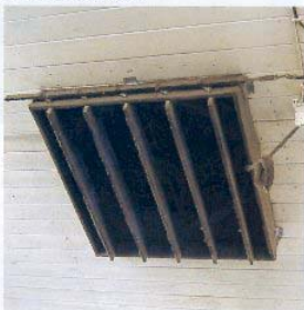
Säätötermostaatilla ohjattu vetomoottori avaa ja sulkee poistoilmaritilää tarpeen mukaan, jos navetta uhkaa jäähtyä liiaksi.
