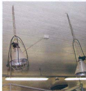
Vasikoiden lämpölamput nykyiset pistokkeen irti rasiasta, mikäli sattuvat putoamaan. Liitosjohdon mitoitusta pitää olla kohdallaan.
