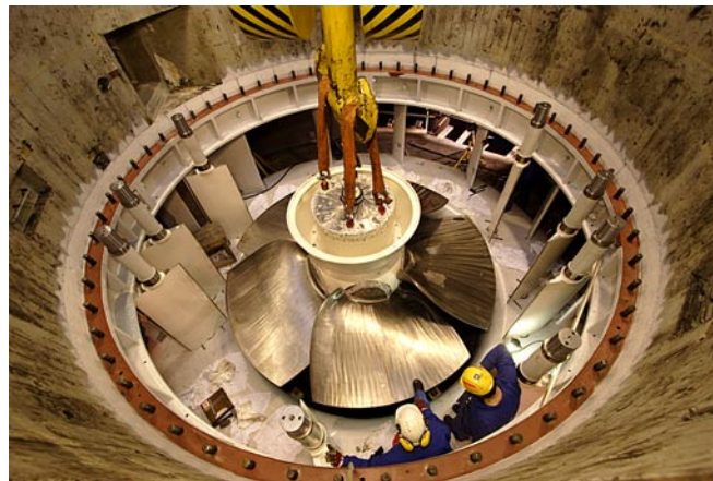
Koneistoja uusimalla voidaan lisätä maakunnan vesivoimatehoa 90 MW
