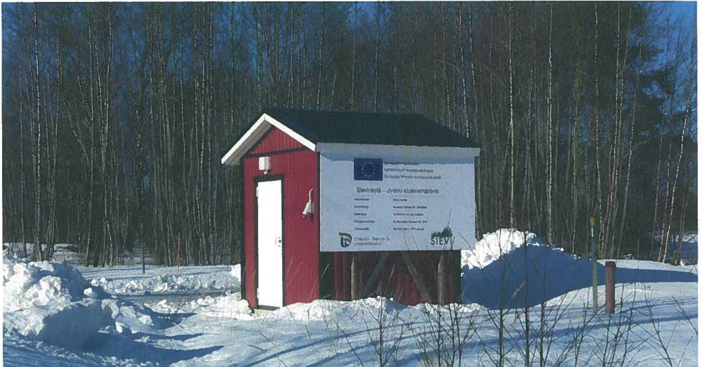
Kuva 2. Jyringin urakka-alueen työmaakyltti, Kokkolantie 320, Jyrinki
